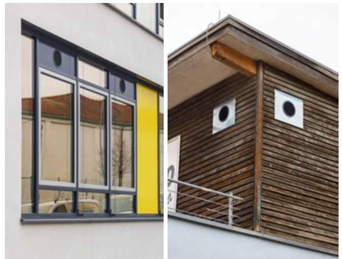
Fortuftauslässe und Außenlufteingänge befinden sich in den Oberlichtern der Fenster bzw. über Eck an der Außenwand
