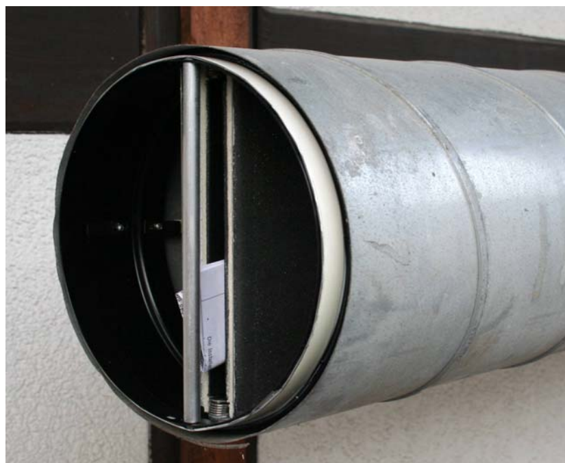
Bild 2: Brandschutzklappe, eingesetzt im Wellrohr
