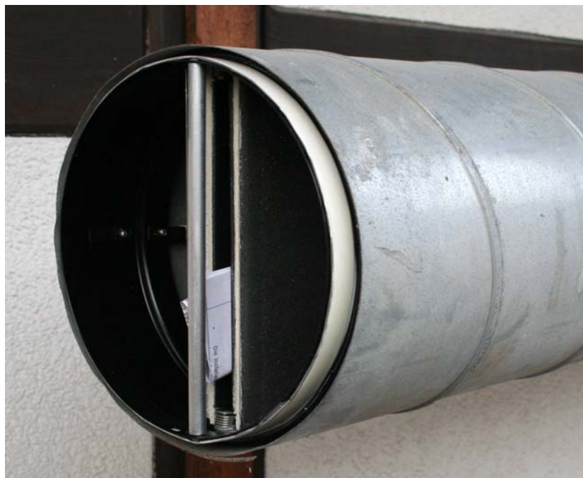
Bild 2: Brandschutzklappe, eingesetzt im Wellrohr
